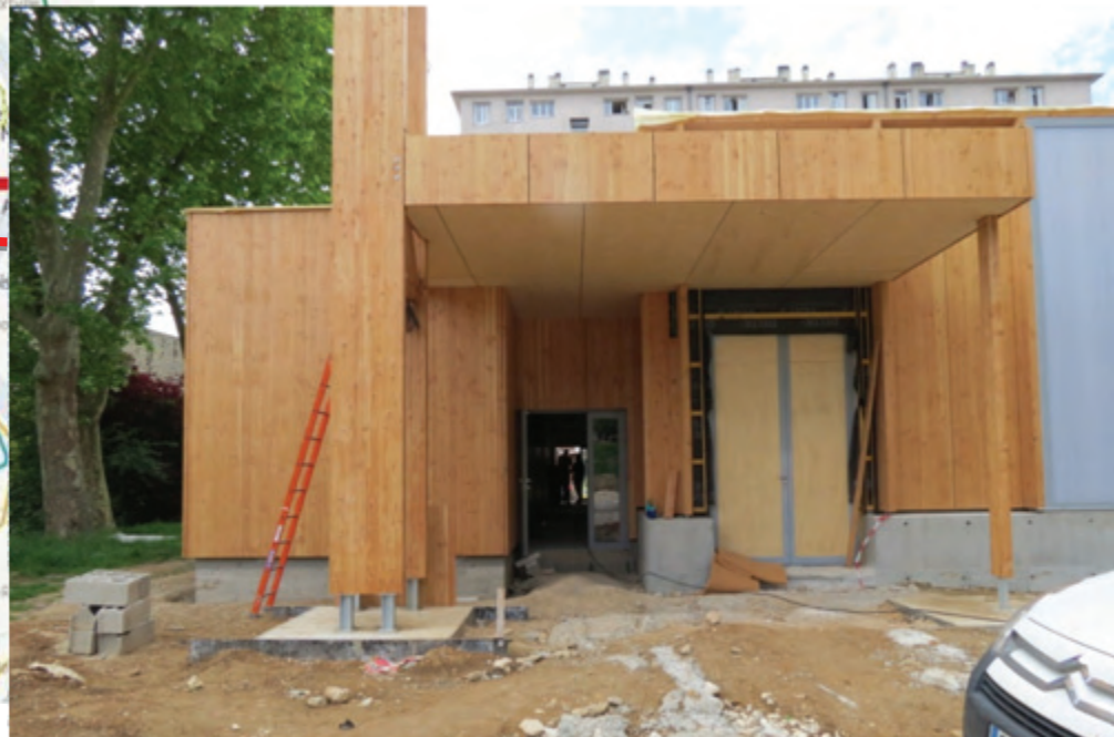
Construction de la chapelle provisoire ND de la Trinité de L'Haÿ-les-Roses
